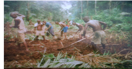
3.Début travaux digues route Nanga à Yemo
