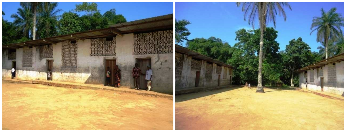
Bâtiments EP Lokendu après réhabilitation sommaire
